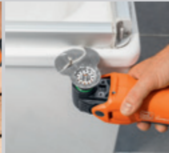
Elastiset tiivistämateriaalit voidaan irrottaa täydellisesti ennen uutta saumausta.
